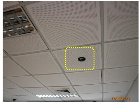
รูปที่ 3-53 ระบบหัวกระจายน้ำดับเพลิงอัตโนมัติ
