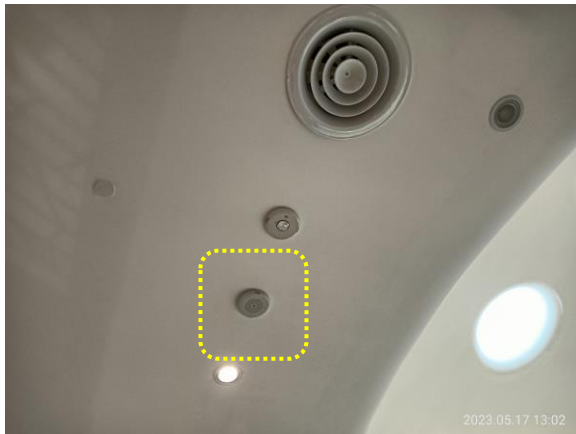
รูปที่ 3-52 อุปกรณ์ตรวจจับความร้อน
