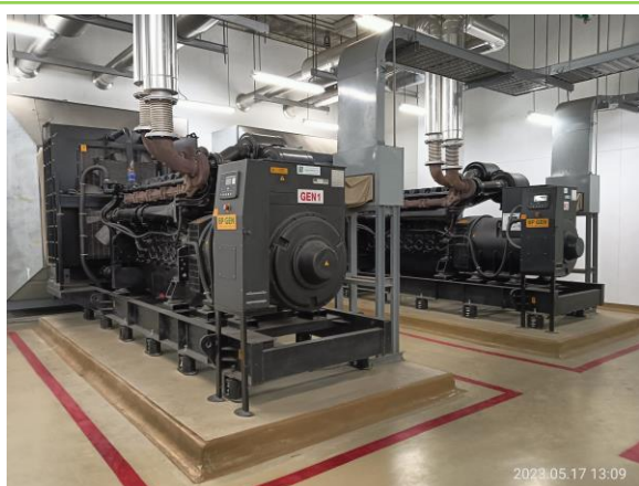
รูปที่ 3-42 เครื่องกำเนิดไฟฟ้าสำรอง
